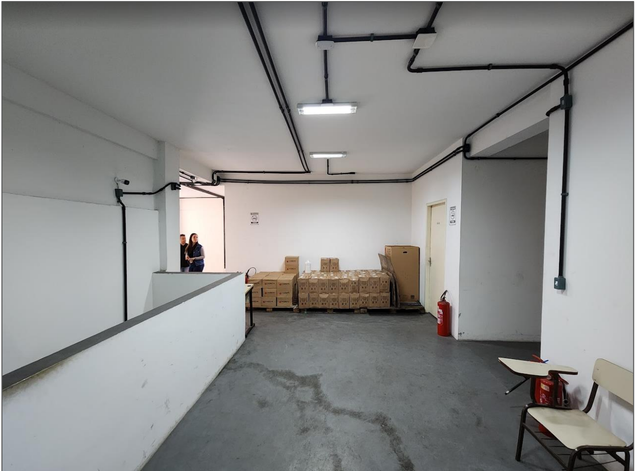
Foto 16: Circulação (2º pavimento)
