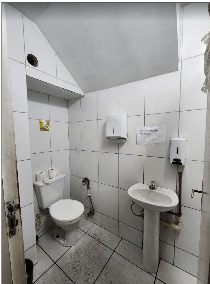
Foto 07: Lavabo. (1º pavimento)
