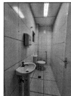
Imagem 13 - Banheiro (2º piso)
