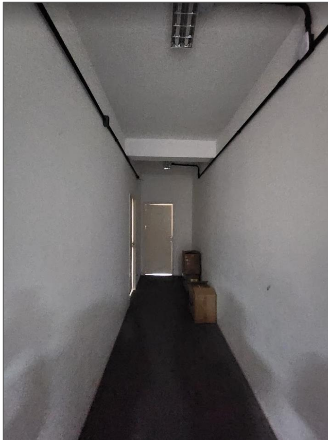
Foto 19: Corredor (2º pavimento)
