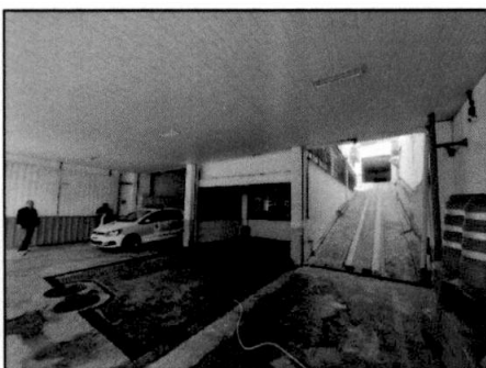
Imagem 05 - Rampa de acesso ao piso superior
