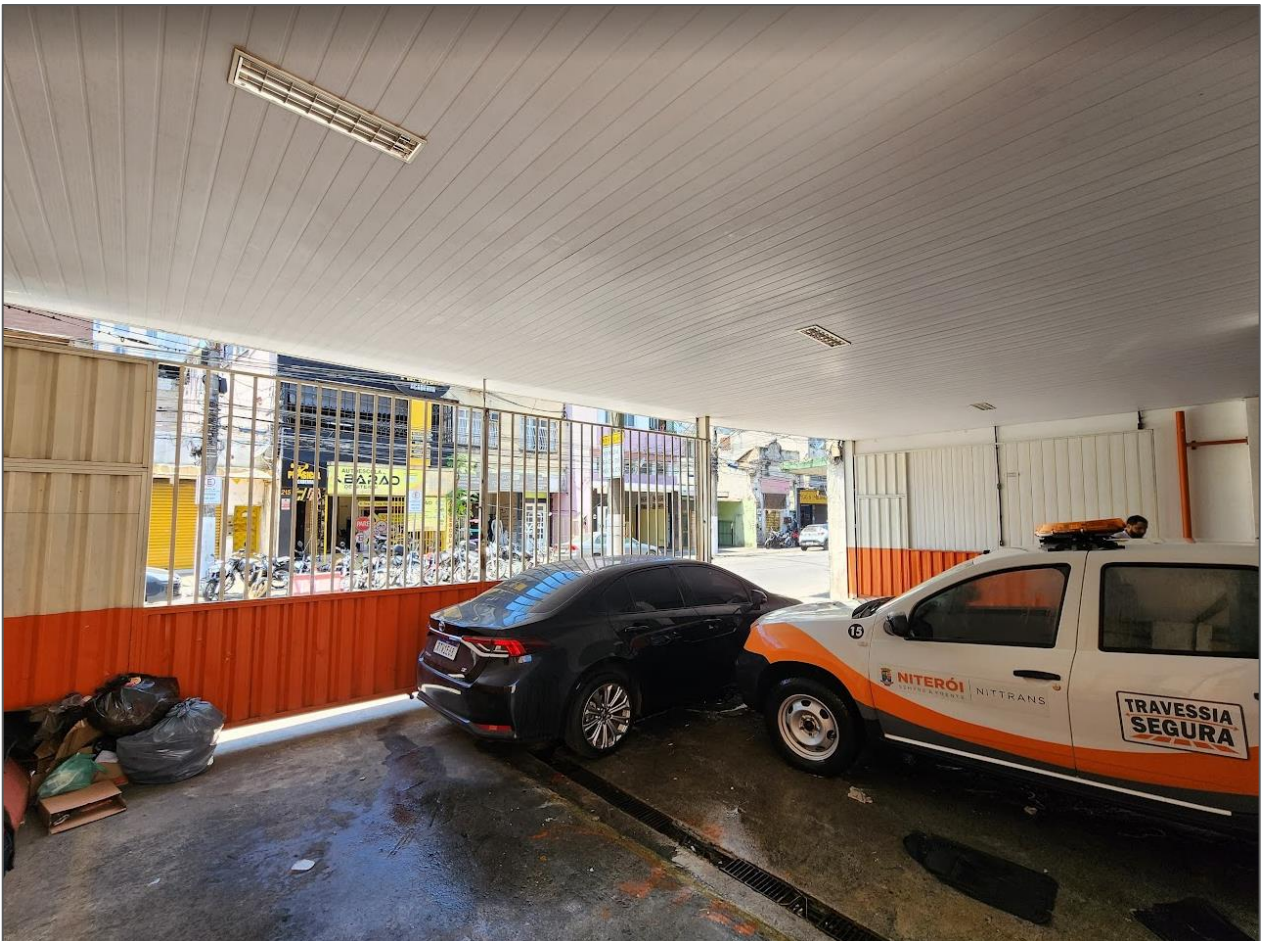
Foto 27: Entrada do imóvel
