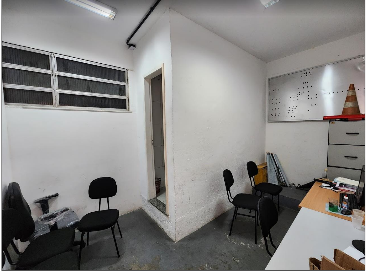
Foto 24: Sala com banheiro (2º pavimento)
